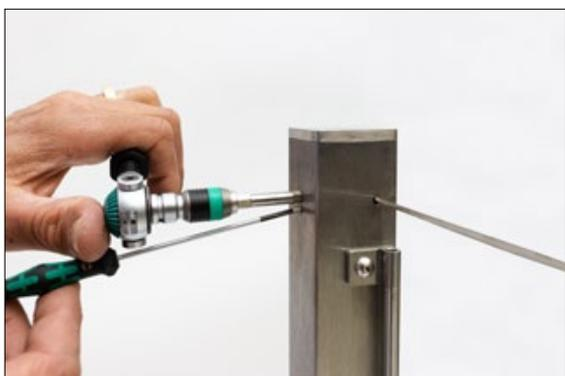
Auf der anderen Zaunseite **das Seilende auf die passende Länge abschneiden** (ca. 15 cm länger als Pfostenende), in den Seilspanner einführen und auf die gewünschte oder erforderliche Endspannung bringen und durch die **M3 Schraube fixieren**.
