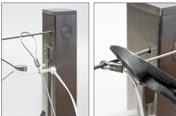
An einem Ende vom Montageeseil (Länge mindestens 2 mal Pfostenlänge) wird eine sehr kleine **Schleife um das Spannseil** (Empfehlung: zuerst Oben) gebildet und mit einer Klemme verpresst (Klemmzange).
