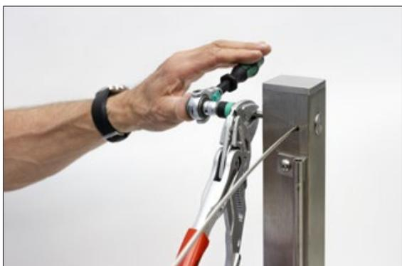
Den Seilspanner und Drahtseil mit einem **Ratschen - Schlüssel mit Inbus (Größe 5) gegen den Uhrzeigersinn drehen bzw. spannen** (dabei durch Unterstützung mit einer Zange die Ratsche gegen Rückdrehen sichern) und durch die M3 Schraube (2,5er Schlitz-Schraubendreher) den Seilspanner mit dem Pfosten, an einer der vier Gewindepositionen, fixieren.
