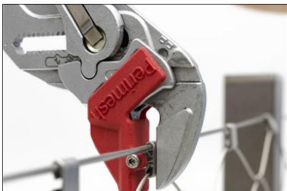
Zum Schluss noch die einzelnen Maschen mit den **Netzclipse** ausrichten und mit der **Presszange** den Clips mit Spannseil und Netz verpressen.
