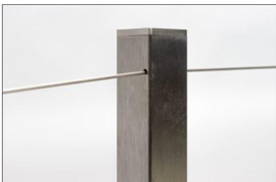
**Horizontale Spannseile unten und oben durch die Mittelpfosten führen** (Seilführung an den Pfosten-Streben hierbei beachten) und auf einer Seite am End- oder Eckpfosten in den im Pfosten eingedrehten Seilspanner einführen. Ggf. die Position vom Durchführungsloch vorher am Seilspanner kennzeichnen. Damit findet man das Durchführungsloch am Seilspanner schneller.
